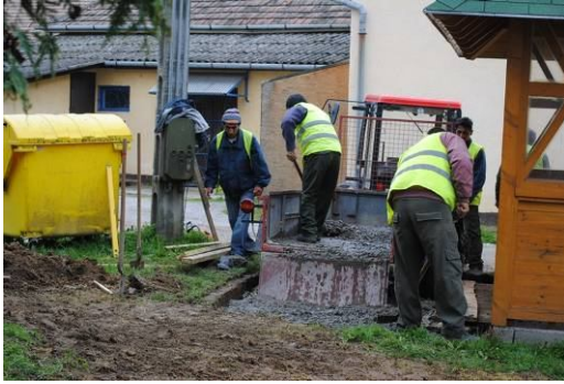
BETONALAP KÉSZÜLT A SZELEKTÍV HULLADÉKGYŰJTŐ KONTÉNEREKNEK
