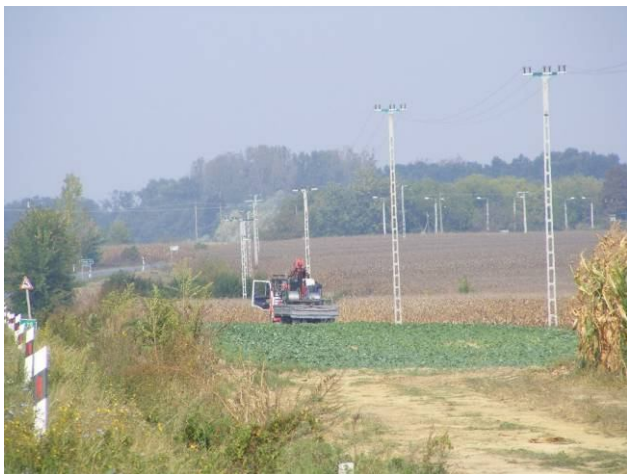
A 20 KV-OS VILLANYVEZETÉK KIÉPÍTÉSE
