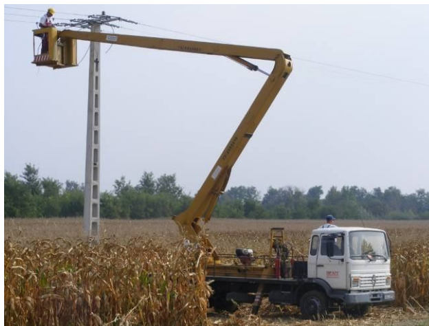
A 20 KV-OS VILLANYVEZETÉK KIÉPÍTÉSE
